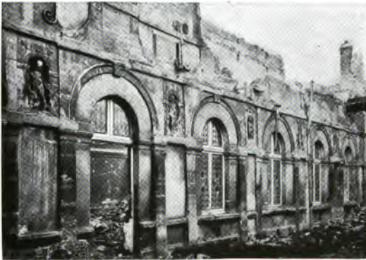
GALLERY FACING THE COURTYARD OF THE HÔTEL FÉRET DE MONTLAURENT
